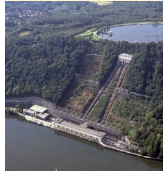
Stromerzeugung durch Aufstauen des Ruhrwassers am Hengsteysee
